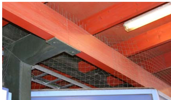
Figur 4. Netting foran åpninger hindrer duer i å finne hvile- og hekkeplasser (Foto: Håvard Øyrehagen).
